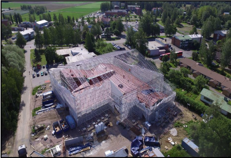
Kuva 12. Uuden terveysaseman rakennustyömaa Hattulan Parolan keskusta-alueella (kesäkuu 2019).
