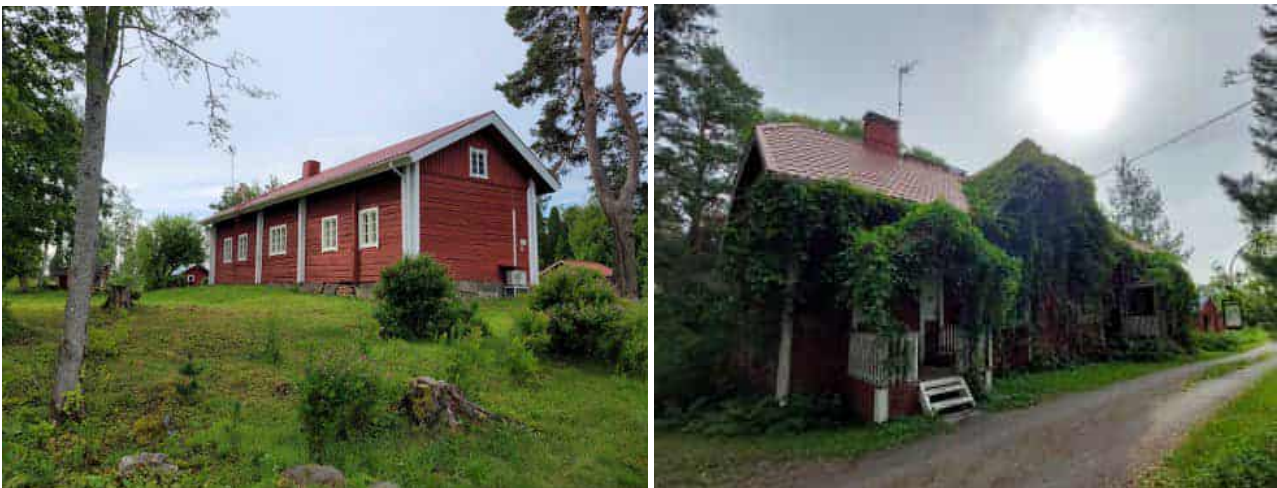
Kuva 26 Tyrvännöntien varrella alueen itäosassa on Porttilan 1800-luvun rakennuksia.
