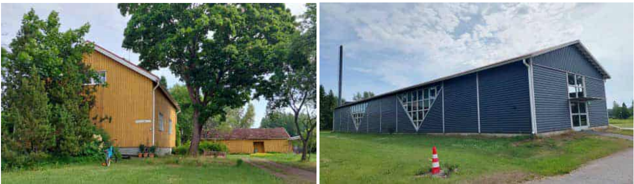
Kuva 54 Puurunkoinen asuinrakennus (vasemmalla) ja uudempi opetusrakennus (oikealla).
