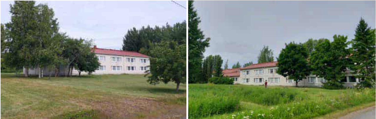
Kuva 53 Asuinrakennukset ovat pääosin rivitalomaisia kokonaisuuksia.
