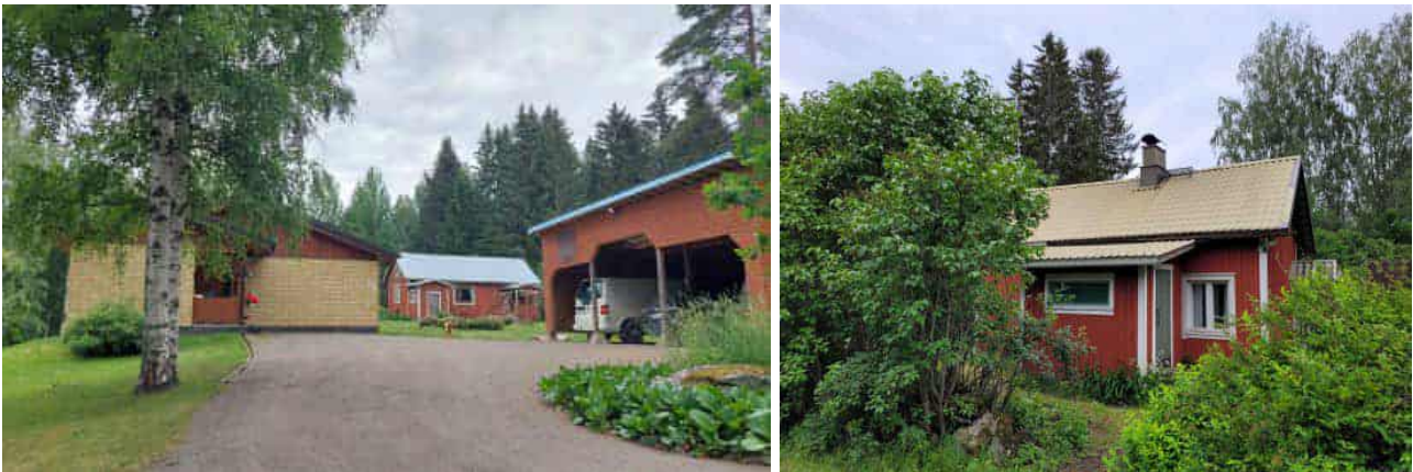
Kuva 63 Alueen asuinrakennukset ovat usealta eri vuosikymmeneltä.
