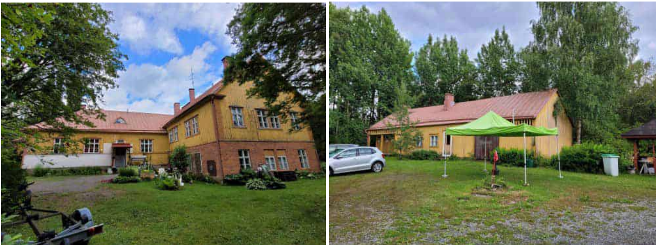
Kuva 90 Rakennuksen julkisivu lännestä (vasemmalla) ja talousrakennus (oikealla).
