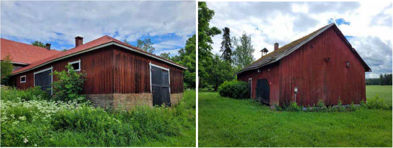
Kuva 84 Kivinauetan lounaisjulkisivu (vasemmalla) ja pienempi talousrakennus (oikealla).
