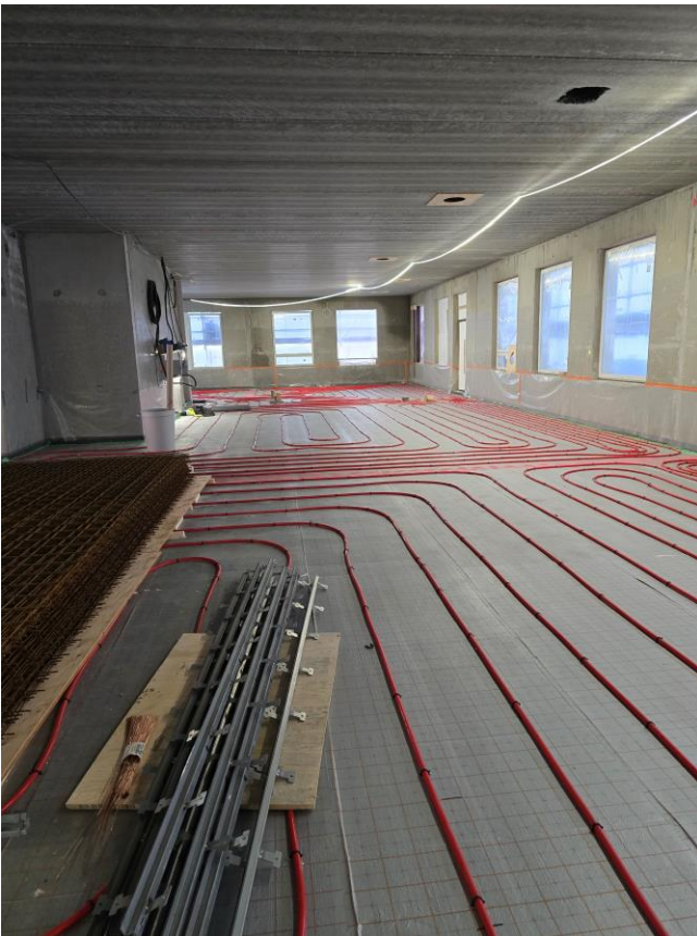
2. krs lattialämmityksiä asennettuna
