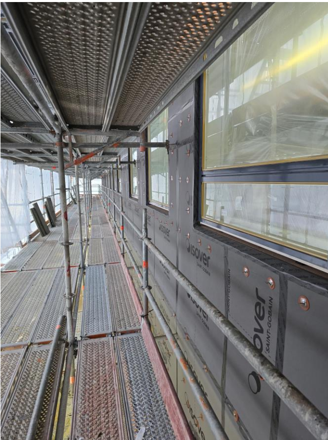
Ulkoseinän lämmöneriste asennukset käynnissä
