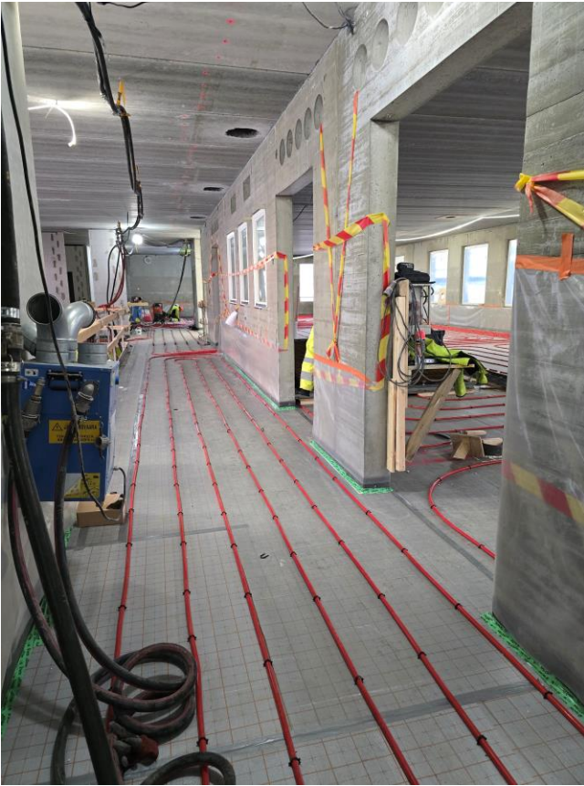
2. krs lattialämmityksiä asennettuna
