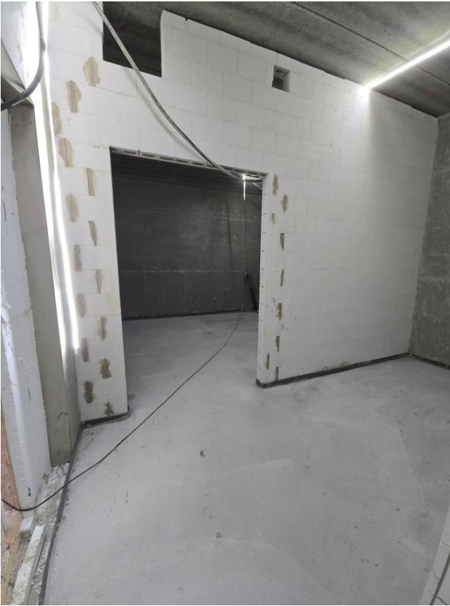
1. krs muurattua väliseinää teknisessä tilassa
