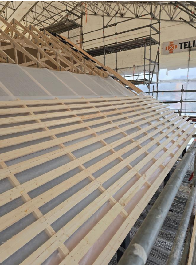
Vesikaton puutyöt käynnissä, kattoristikot asennettu. Aluskatteen ja ruodelautojen asennus käynnissä
