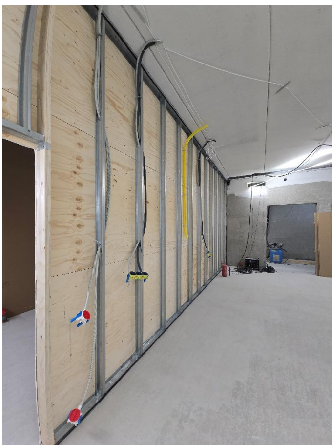
1. krs väliseinäasennus käynnissä
