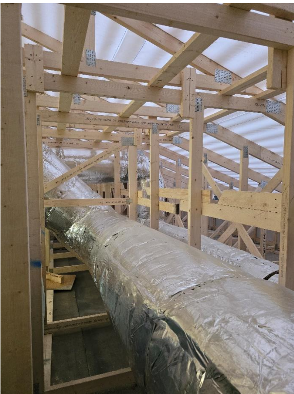
Yläpohjan IV-kanavien asennus ja eristys käynnissä
