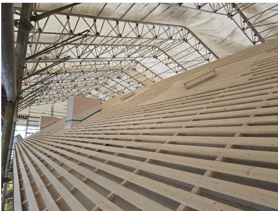
Vesikaton puutyöt valmiit, vesikatteen asennus alkaa vk 5
