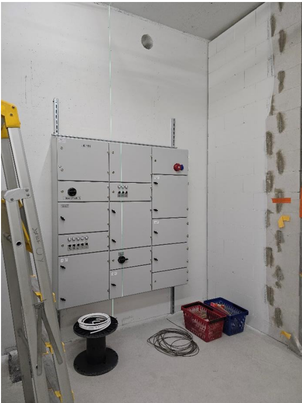
Sähkökeskukset asennettu
