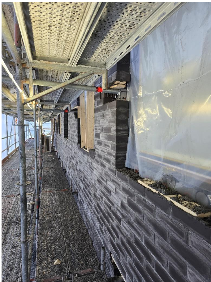
Julkisivun muuraustyöt käynnissä
