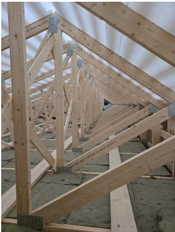
IV-konehuoneen katon paloeristeet asennettu
