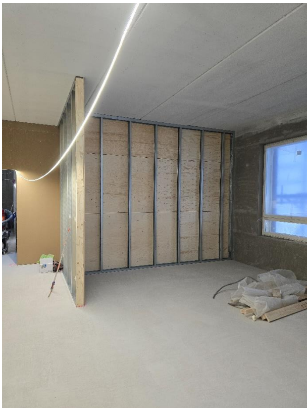
2. krs väliseinätyöt käynnissä
