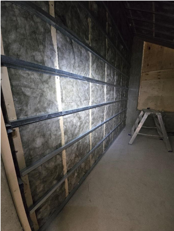
Opinportaan alapuolisen neuvottelutilan ääneneristys asennettu
