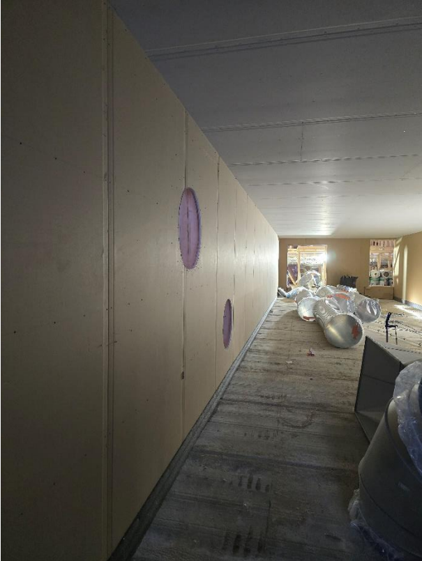
IV-konehuoneen sisäpuolen levytys valmis
