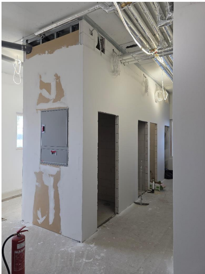
1. krs käytävien tasoitetyöt valmiit
