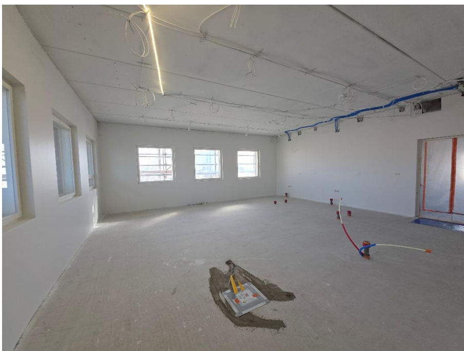
1. krs luokkatilat siivottu P1-luokan mukaisesti IV-asennuksia varten
