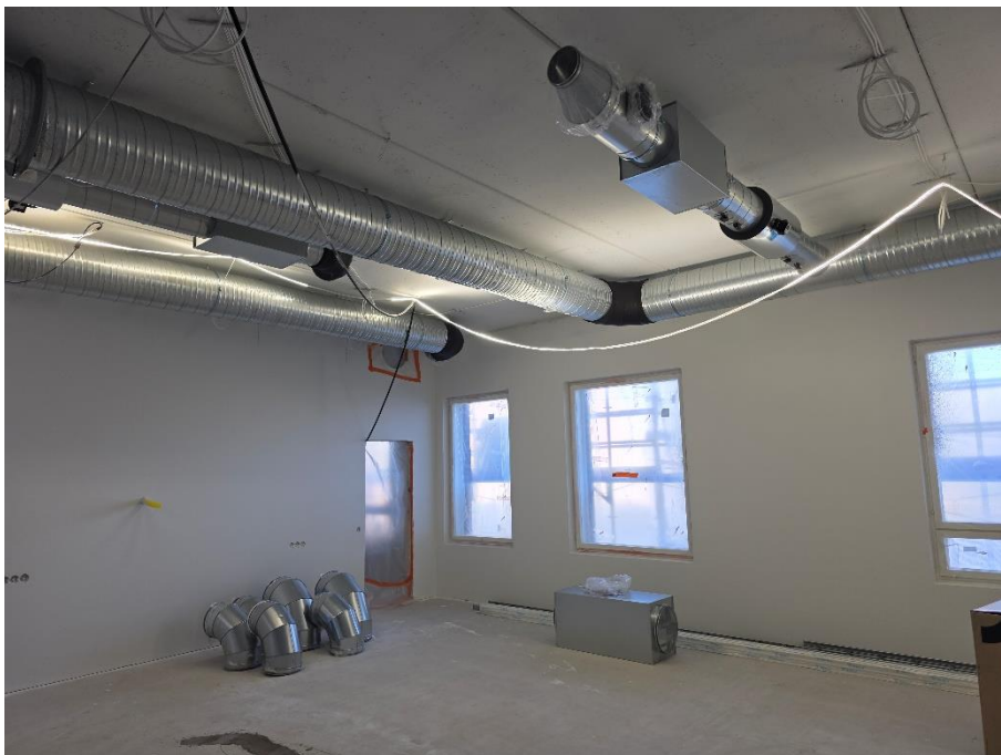
1. krs luokkahuoneiden IV-asennukset käynnissä
