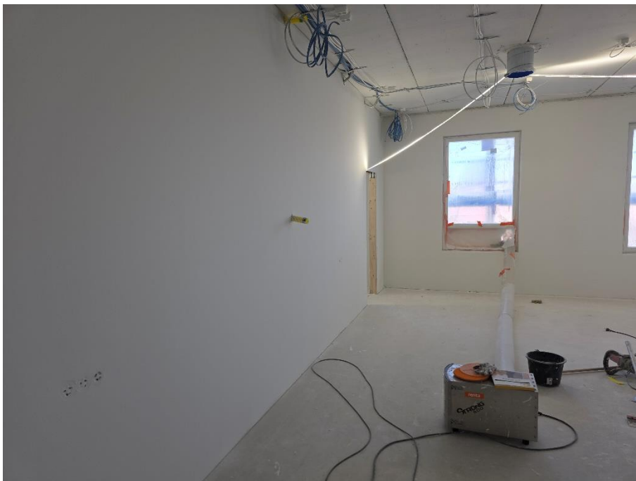
2. krs luokkatilojen pohjamaalaus käynnissä
