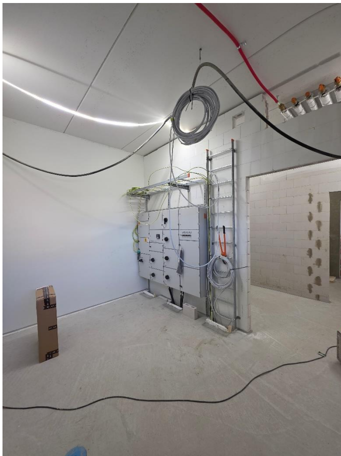
Teknisen tilan lattioiden valmistelu pinnoitusta varten käynnissä
