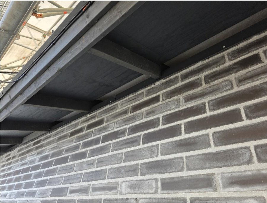
Räystäiden myrskypelttien asennus käynnissä
