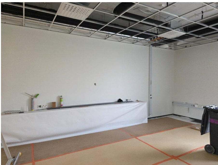
Mallihuoneen vinyylilaatat ja kalusteet asennettu
