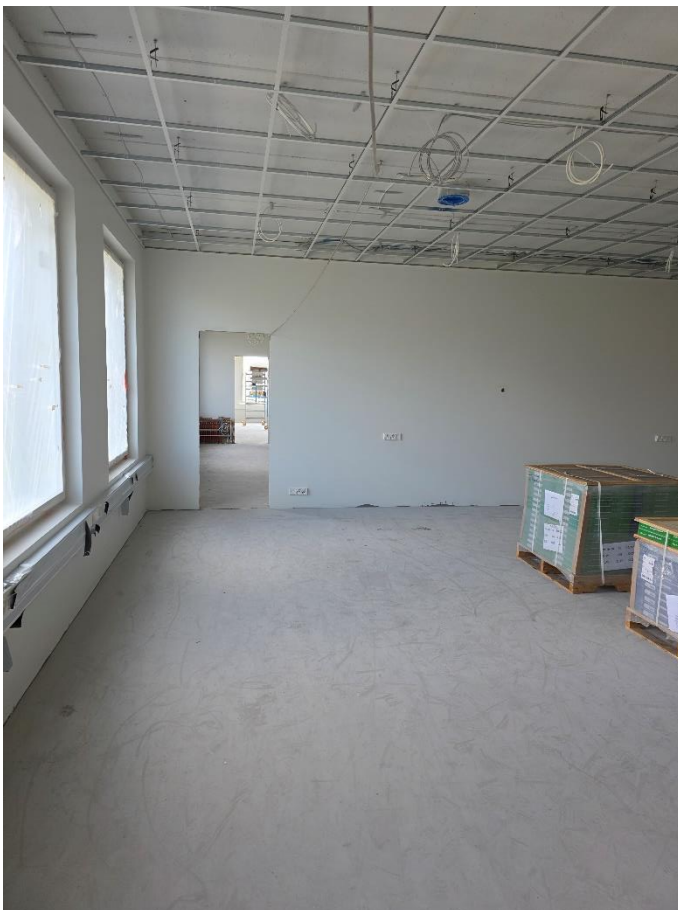
2. krs luokkien alakattorungot asennettu
