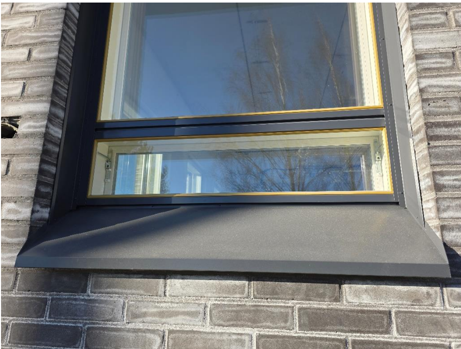
Ikkunapellit asennettu
