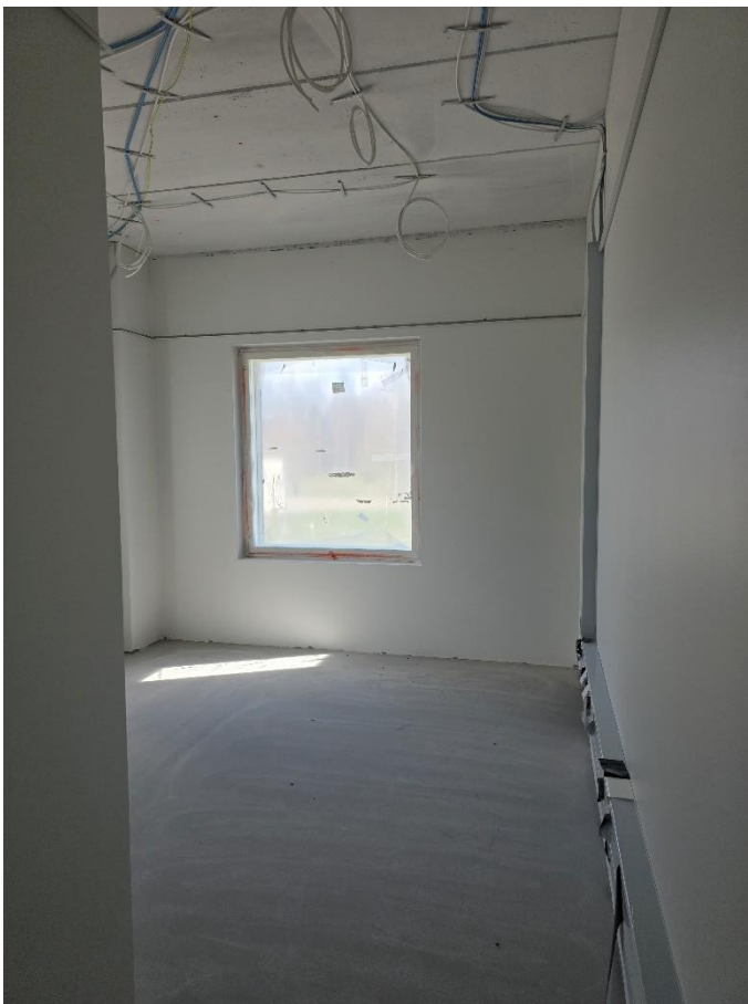
2. krs lattiatasoitukset tehty
