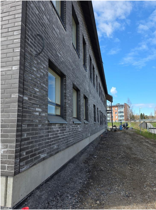
Julkisivumuuraus viimeistelty, ikkunapellit asennettu
