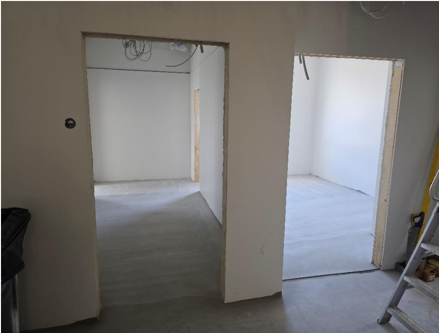
2. krs lattiatasoitukset tehty
