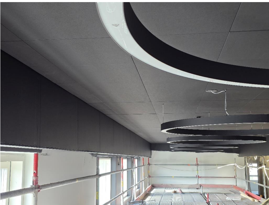
Korkean aulatilän alakattolevyt ja valaisimet asennettu
