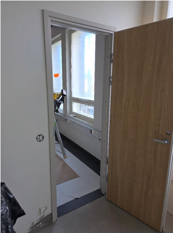
Mallihuoneen ovet asennettu ja listoitettu
