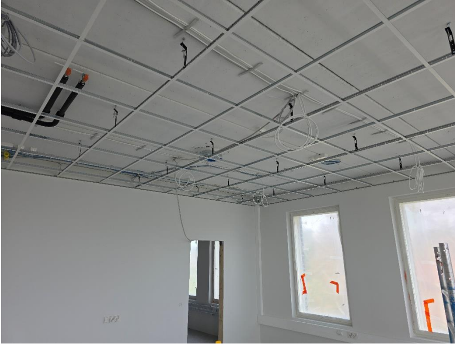
2. krs luokkien alakattorungot asennettu
