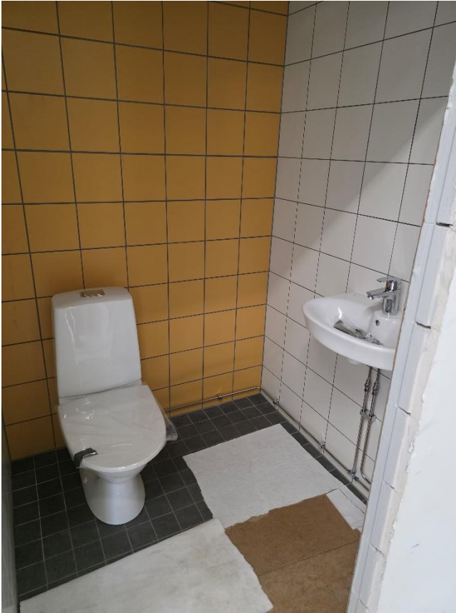
WC-tilojen kalustukset käynnissä
