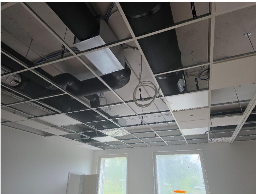
Luokkahuoneiden alakattorungot ja tekniikkalevyt asennettu
