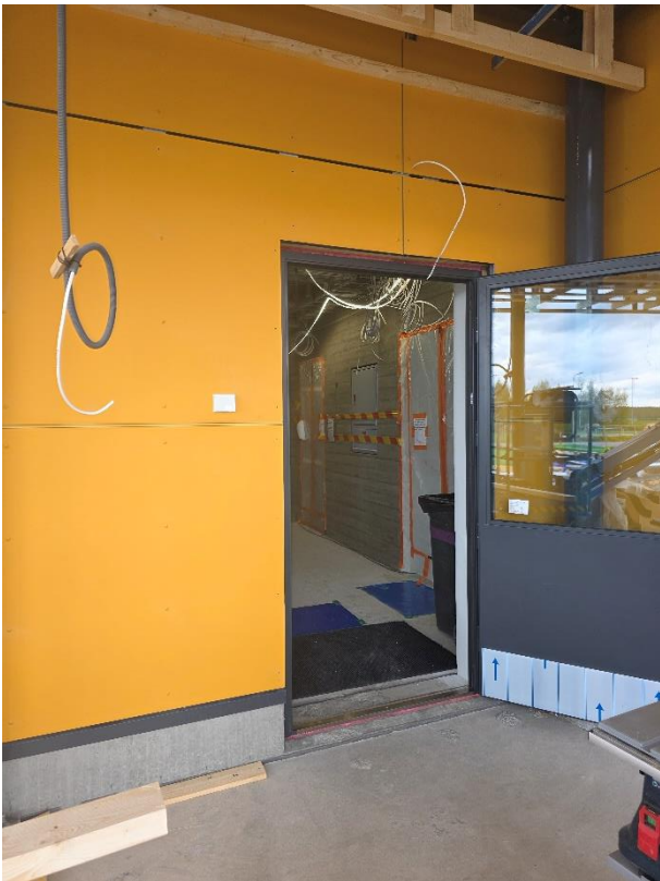
Julkisivun levytykset ja teräsovien asennus käynnissä
