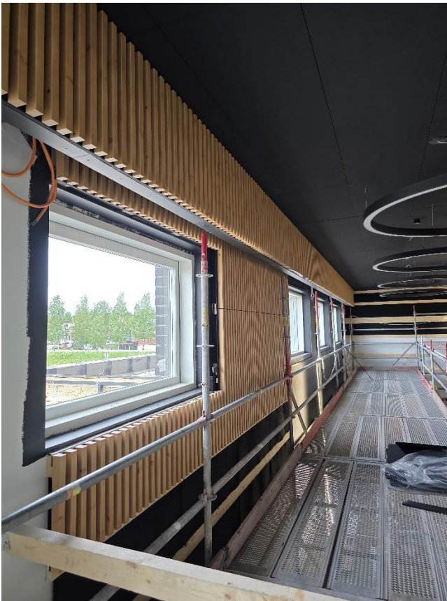
Rimaelementtien asennus aulatilaan käynnissä
