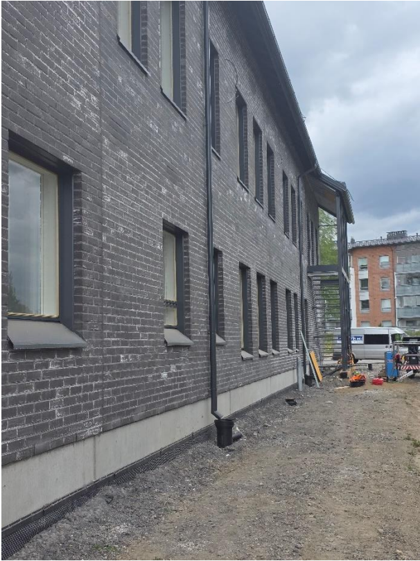
Rännit ja syöksytorvet asennettu
