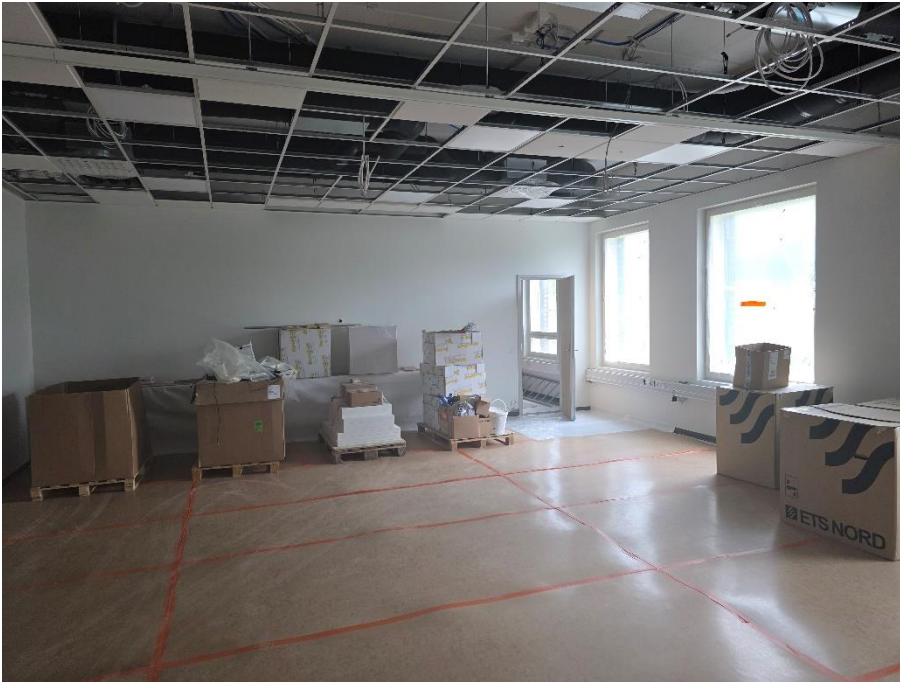
Luokkahuoneiden alakattorungot ja tekniikkalevyt asennettu
