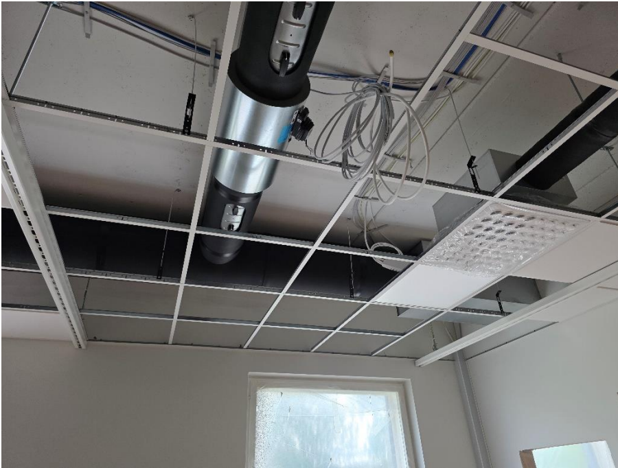
Luokahuoneiden alakattorungot ja tekniikkalevyt asennettu
