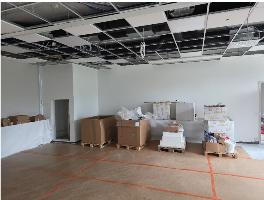
Luokahuoneiden vinyylit ja kalusteet pääosin asennettu
