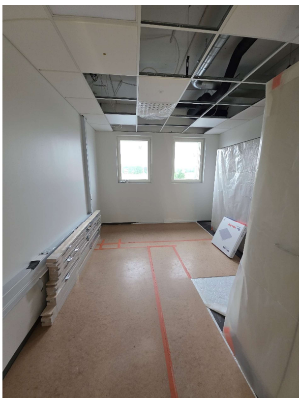
Alakattojen rungot valmiit
