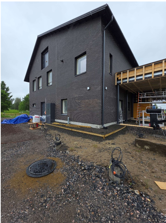
Rakennuksen sepelireunuksien teko työn alla
