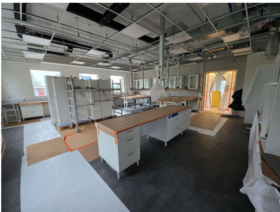
Labra luokan kalusteet asennettu
