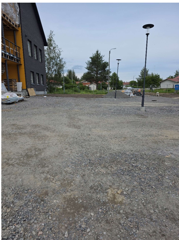
Asfalttipohjat valmiit ja pihavalaisimet asennettu
