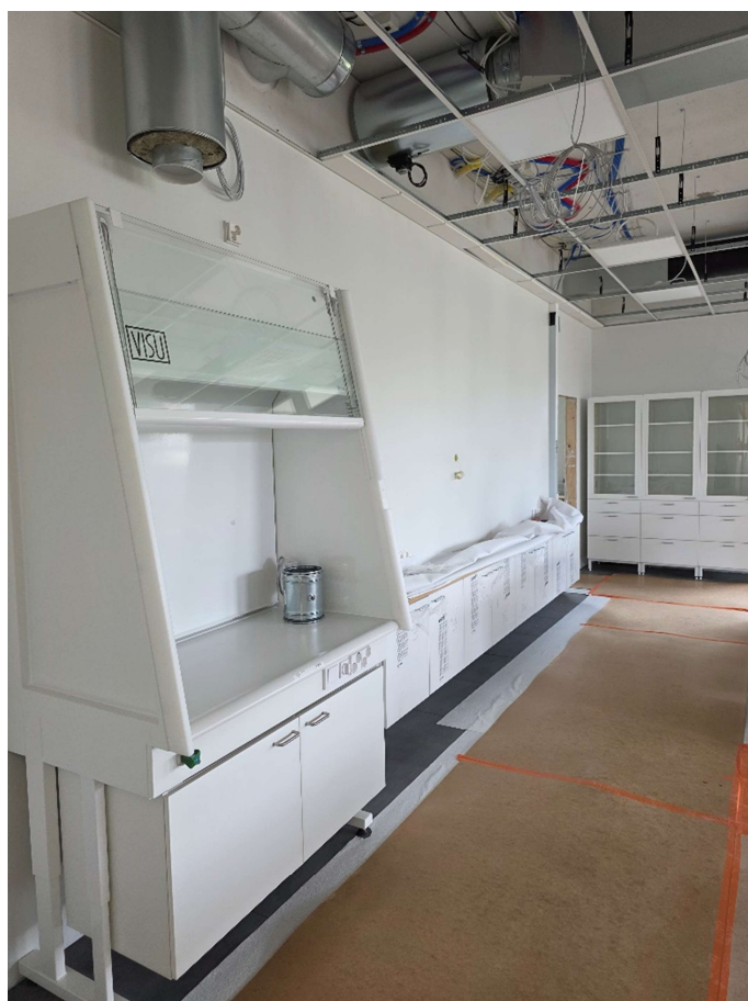
Labran kalusteet asennettu
