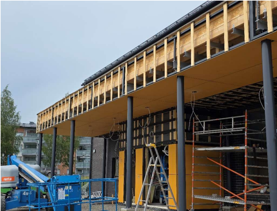
Sisäänkäyntikatoksen levytys käynnissä
