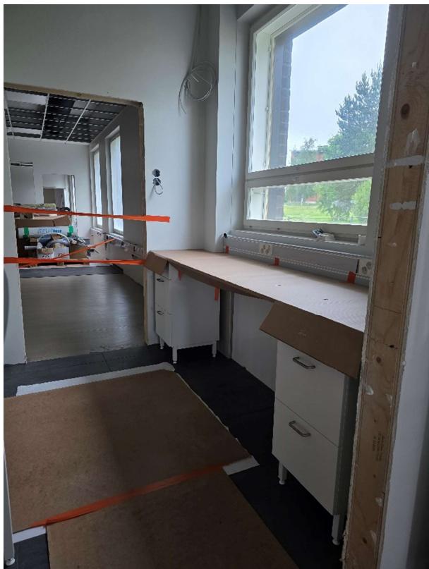
Labran varaston kalusteet asennettu
