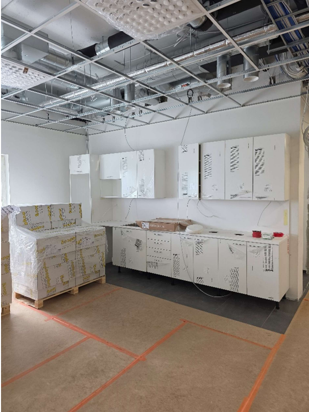
Opiskelijatilan kalusteet asennettu
