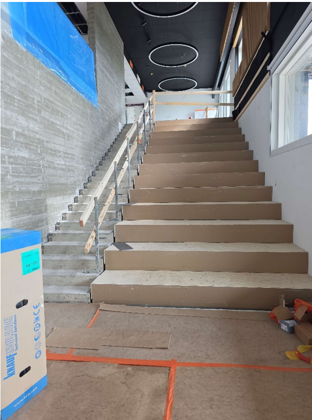
Opinportaan istuinosien rungot valmiit
