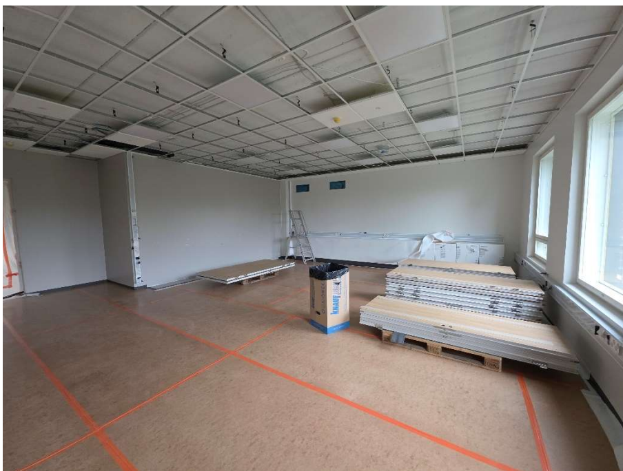
Alakattojen rungot valmiit
