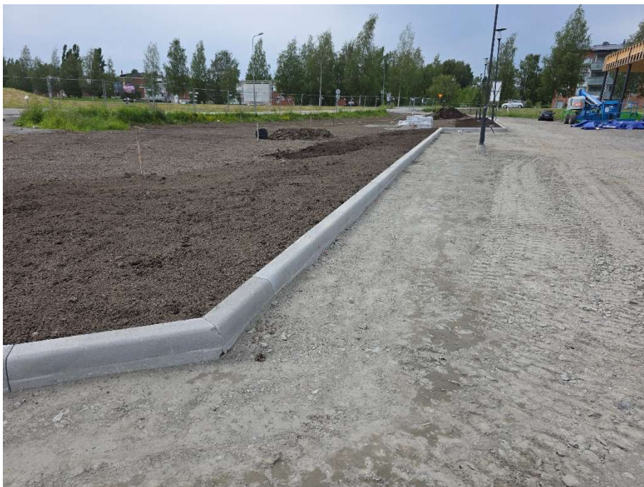
Nurmi- ja istutusalueet työn alla, reunakivet asennettu
