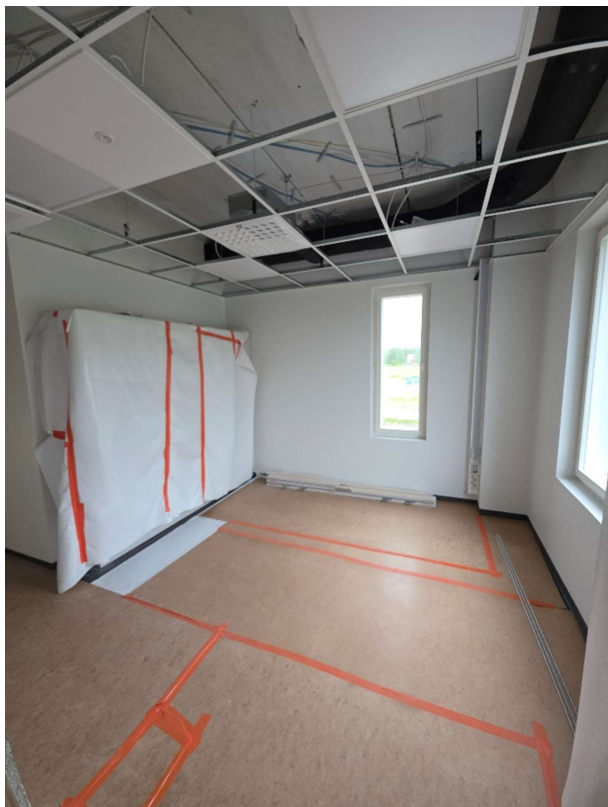
Alakattojen rungot ja kalusteasennukset valmiit
