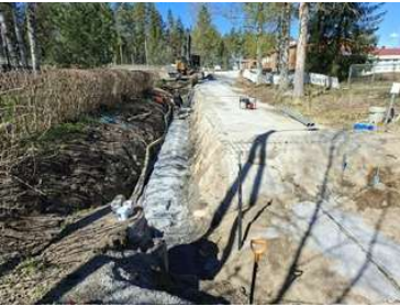
KUVA. Vesi- ja viemäryön kaivuvaihe Nuohoojantiellä. (pe 8.5.2026.)
