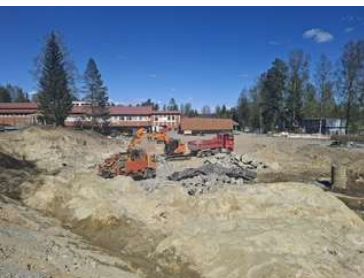
KUVA. Kallioporaukset ja louhintatyöt käynnissä. (pe 8.5.2026)
