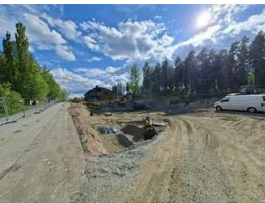
KUVA 2. Matalamman perustustason louhinnat ovat pääosin tehty. (pe 22.5.2026)
