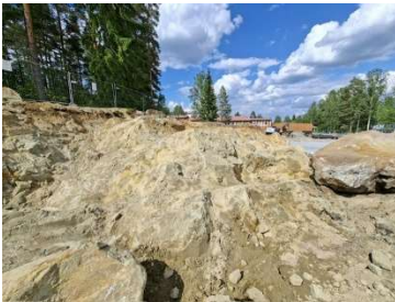
KUVA 1. Tulevaa perustustason kalliolouhintaa. (pe 5.6.2026.)
