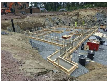
KUVA 2. Kellarikerroksen ensimmäiset anturat on valettu. (pe 5.6.2026)
