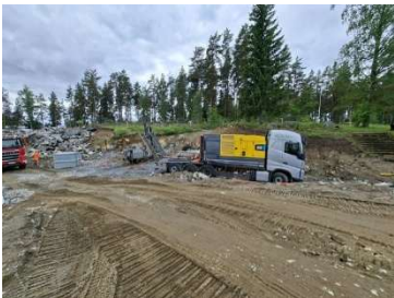
KUVA 2. Maalämpökaivojen poraus. (pe 12.6.2026)
