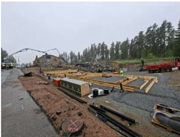
KUVA 1. Perustusten valutyöt. (pe 12.6.2026.)
