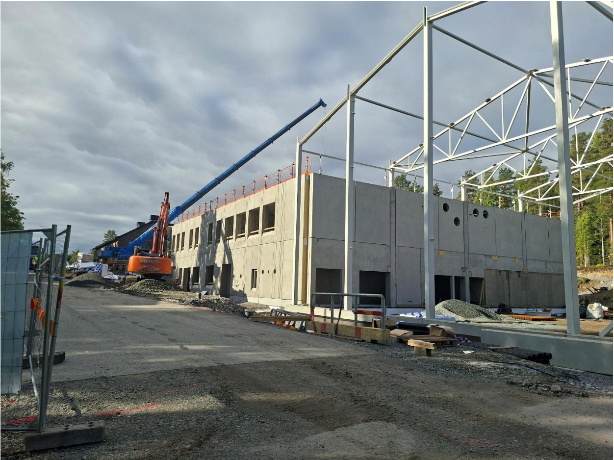
Kuva 2. 1. kerroksen seinäelementit lähes asennettu.
