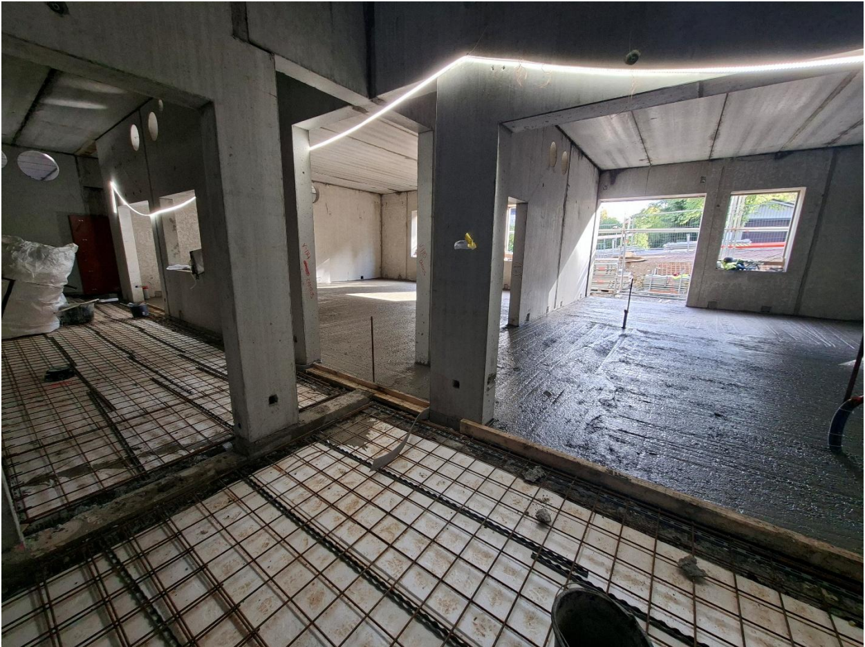
Kuva 2. Teknisentyön tilojen lattioiden valu käynnissä.
