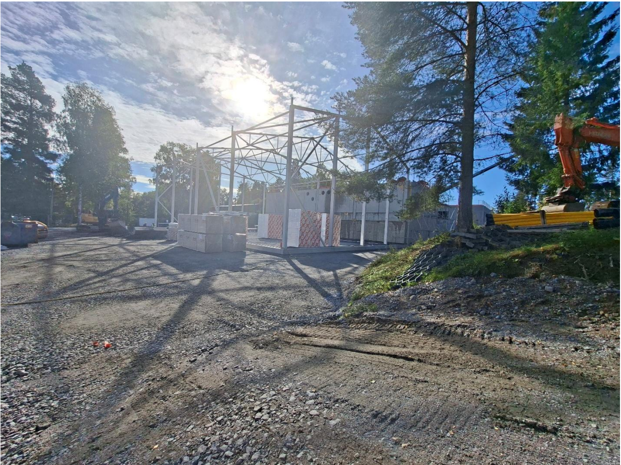
Kuva 1. Liikuntahallin pohjat valmiit. Ensi viikolla alkaa maanvaraisenlattian valuvalmistelut.
