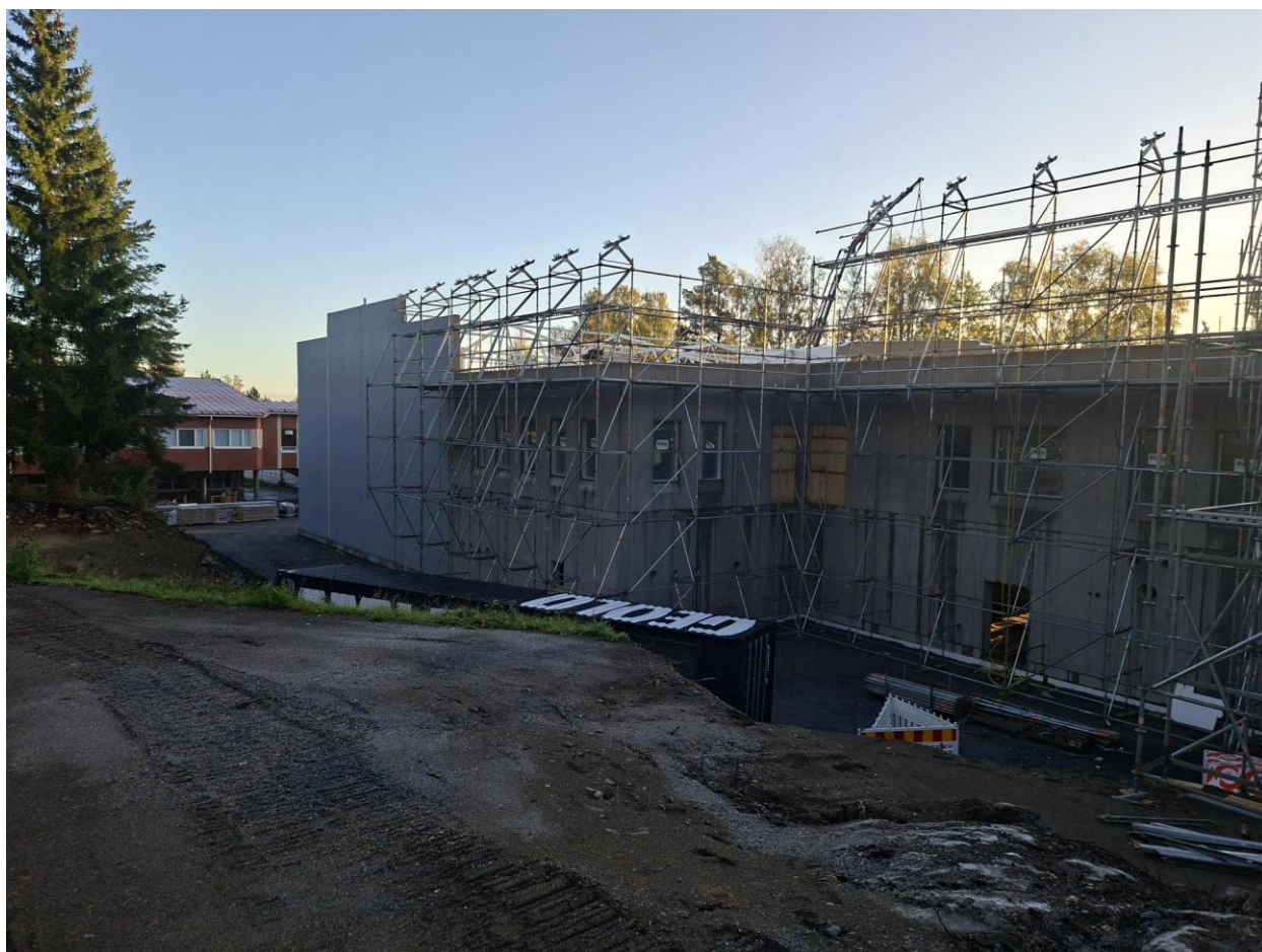
Kuva 1. Sääsuojan runkoa matalan vesikatonkohdalla.
