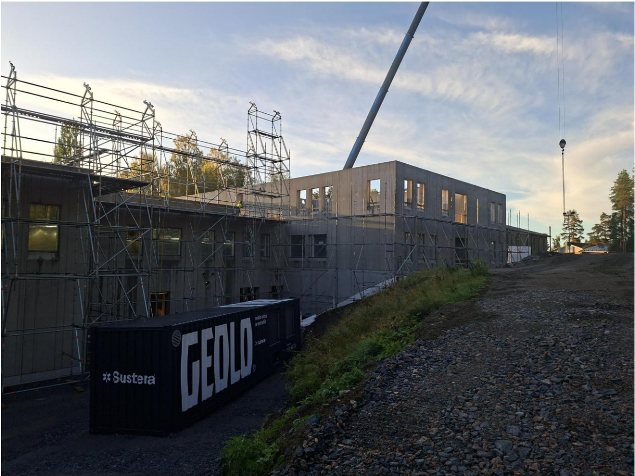
Kuva 2. 2. kerroksen ulkoseinäelementit paikoillaan.
