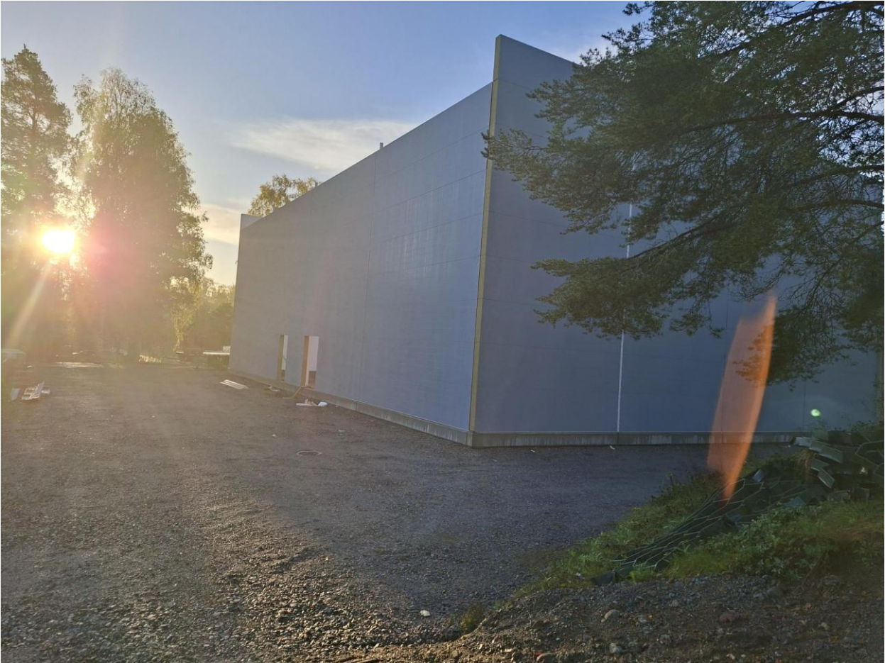
Kuva 3. Liikuntahallin sandwich-elementtiasennus käynnissä.
