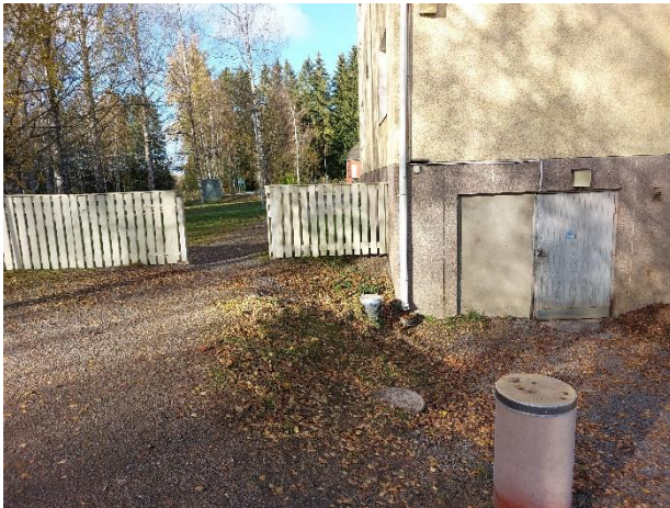
Kuva 6. Yleiskuvaa rakennuksen vierustalta.
