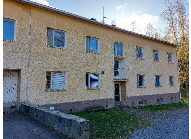
Kuva 5. Yleiskuvaa rakennuksen vierustalta.
