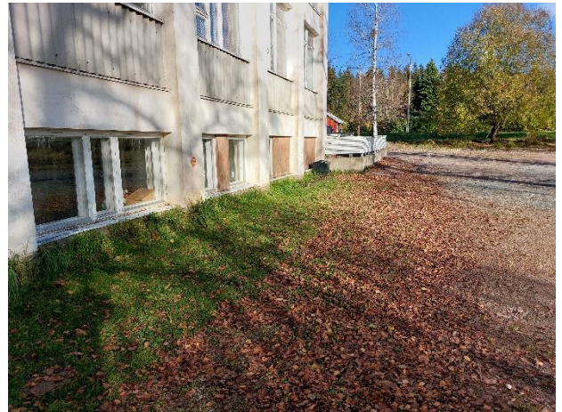
Kuva 7. Yleiskuvaa rakennuksen vierustalta.
