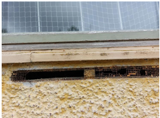
Kuva 27. Liikuntasalin vanha korvausilmaventtiili.
