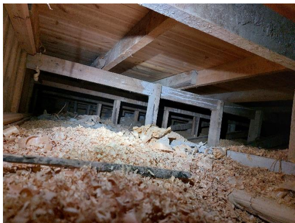
Kuva 41. Näyttämön alla on ilmatila ja purutäyttö.
