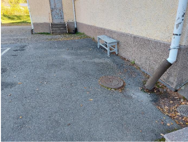
Kuva 4. Yleiskuvaa rakennuksen vierustalta.
