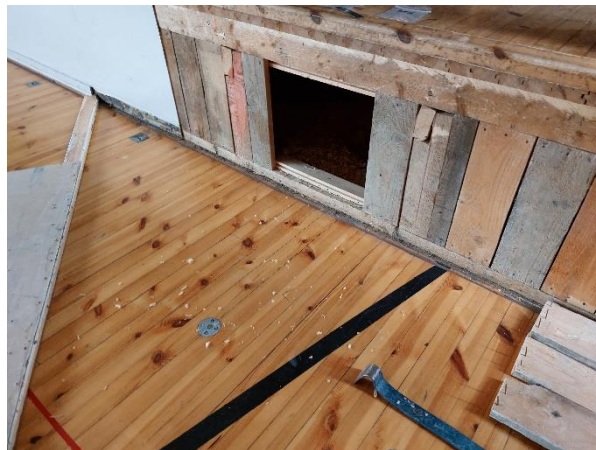
Kuva 40. Liikuntasalin näyttämön alapuolisia rakenteita tutkittiin rakenneavauksin.
