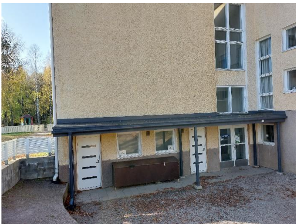
Kuva 8. Yleiskuvaa rakennuksen vierustalta.
