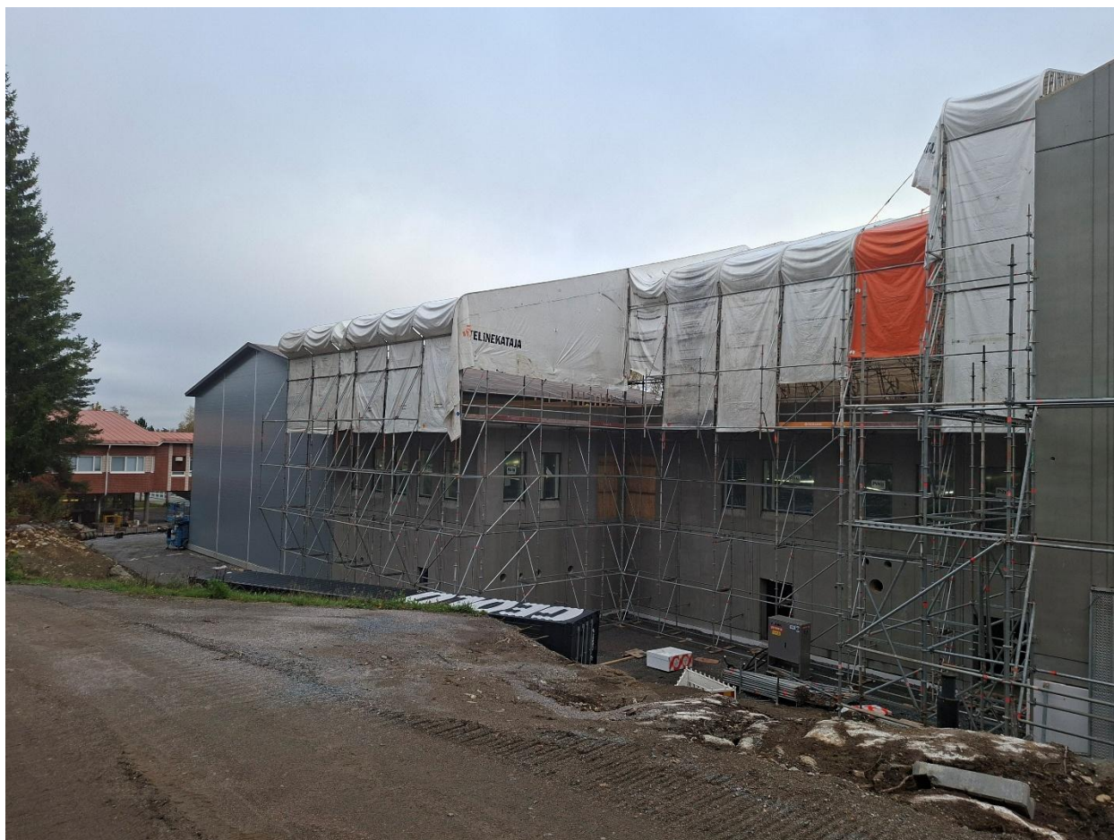
Kuva 1. Sääsuoja matalan vesikaton kohdalla.
