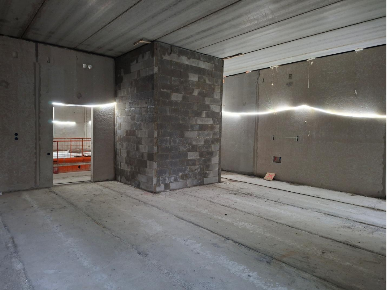
Kuva 3. Väliseinä muuraukset käynnissä.
