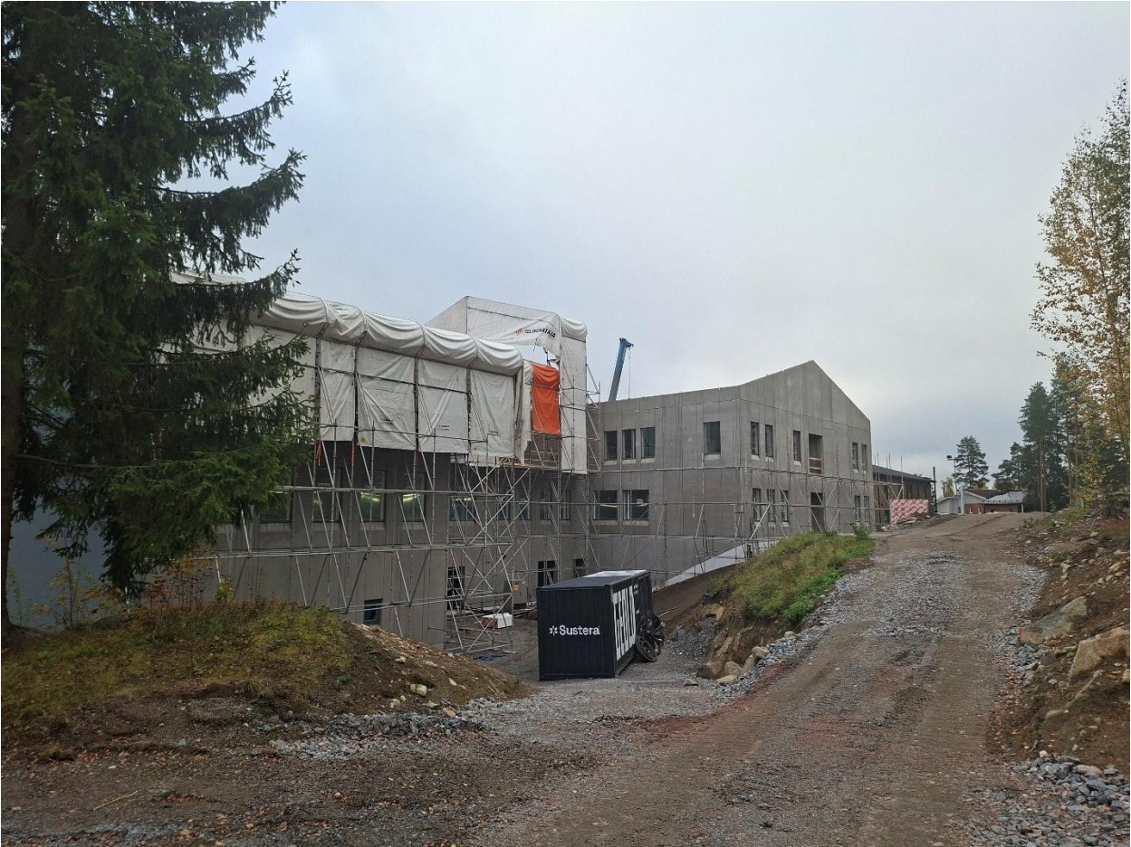
Kuva 2. Betonielementtirunko valmis.
