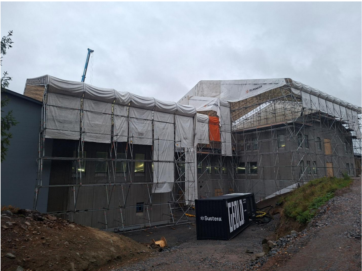
Kuva 1. Sääsuoja lähes valmis.
