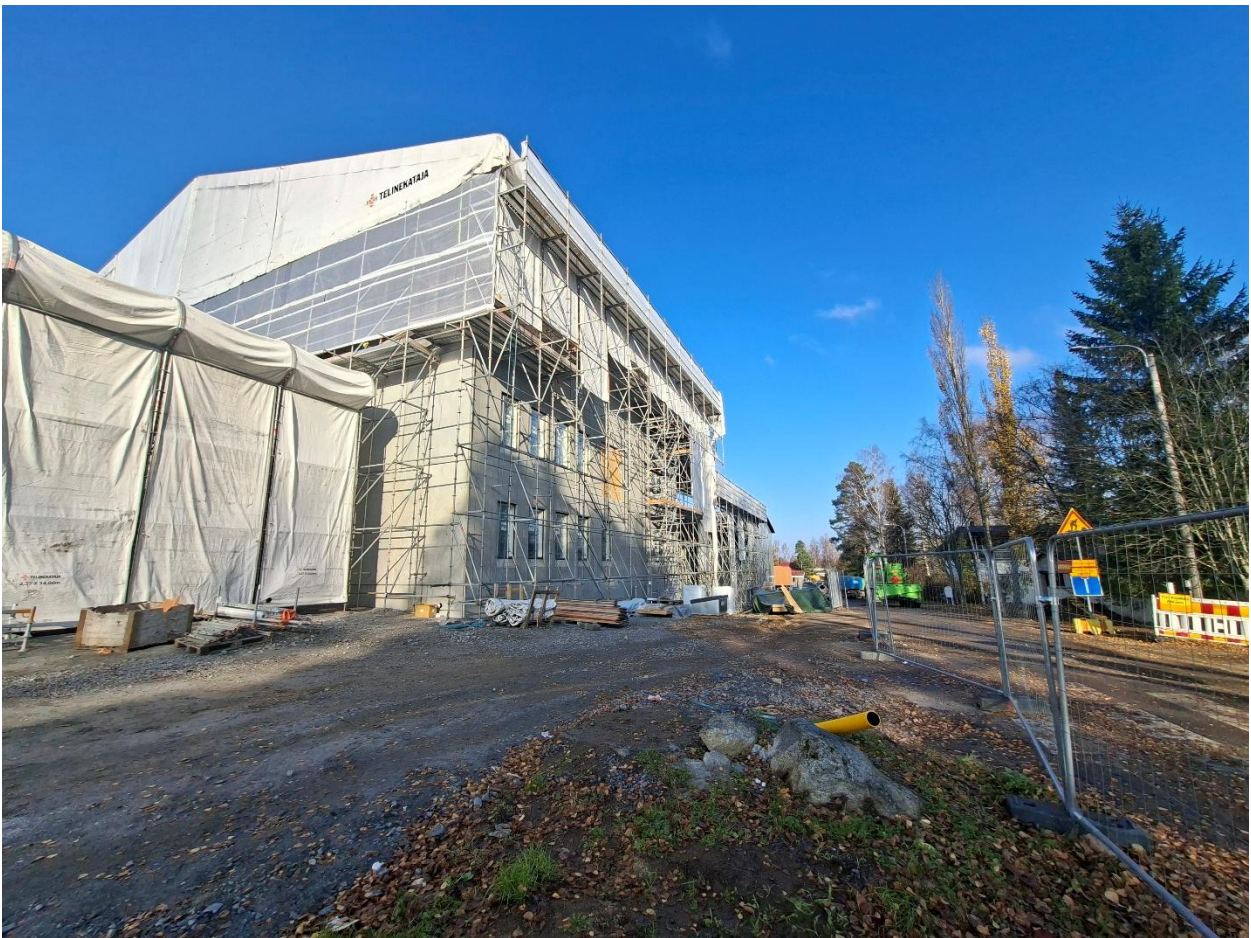
Kuva 1. Sääsuoja valmis.
